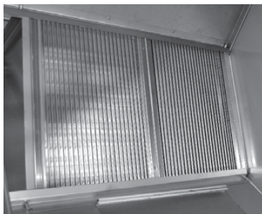
Пластинчатый рекуператор (рис. 12)
