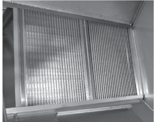
Пластинчастий рекуператор (рис. 25)
