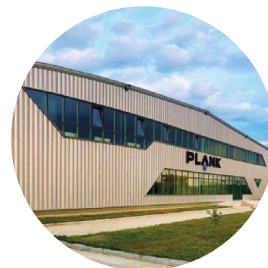
Plank Electrotechnic, м. Біла Церква, Київська обл.
