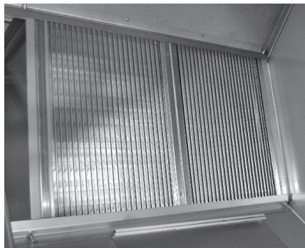
Пластинчастий рекуператор (рис. 12)
