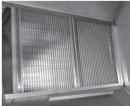
Пластинчастий рекуператор (рис. 12)
